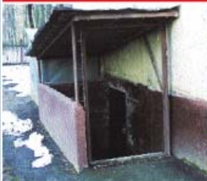
В подвале жилого дома
